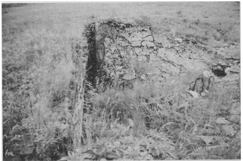
Krematorium II, Birkenau, Zustand 1991. Man achte auf die nach Kriegsende versuchte Einbringung einer "Einwurfklue für Zyklon B" (rechts im Bild, vgl. Vergrößerung S. 29). Sie ist nicht gelungen. Eisenarmierung und Eisenträger haben dies verhindert.
